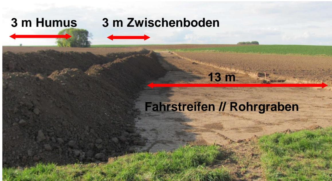
Die Baufeldbreite von mindestens 19 m ist erforderlich, um Bodenvermischungen zu vermeiden. Humus, Zwischenboden und Rohrgrabenaushub werden getrennt voneinander gelagert. In den Waldbereichen reduziert sich das Baufeld auf 12 m Breite.
